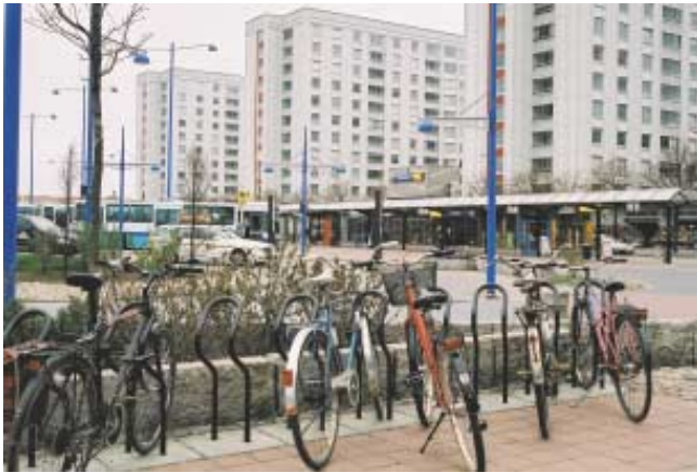
Høyhus rett mot byssholdeplassen. Boligene har gode halvprivate skjermede utearealer mellom lamellene.
