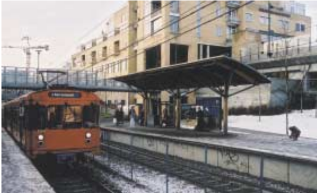
Det åpne hjørnet markerer forbindelsesleddet. Bussholdeplassen på det øvre nivået opp til høyre
