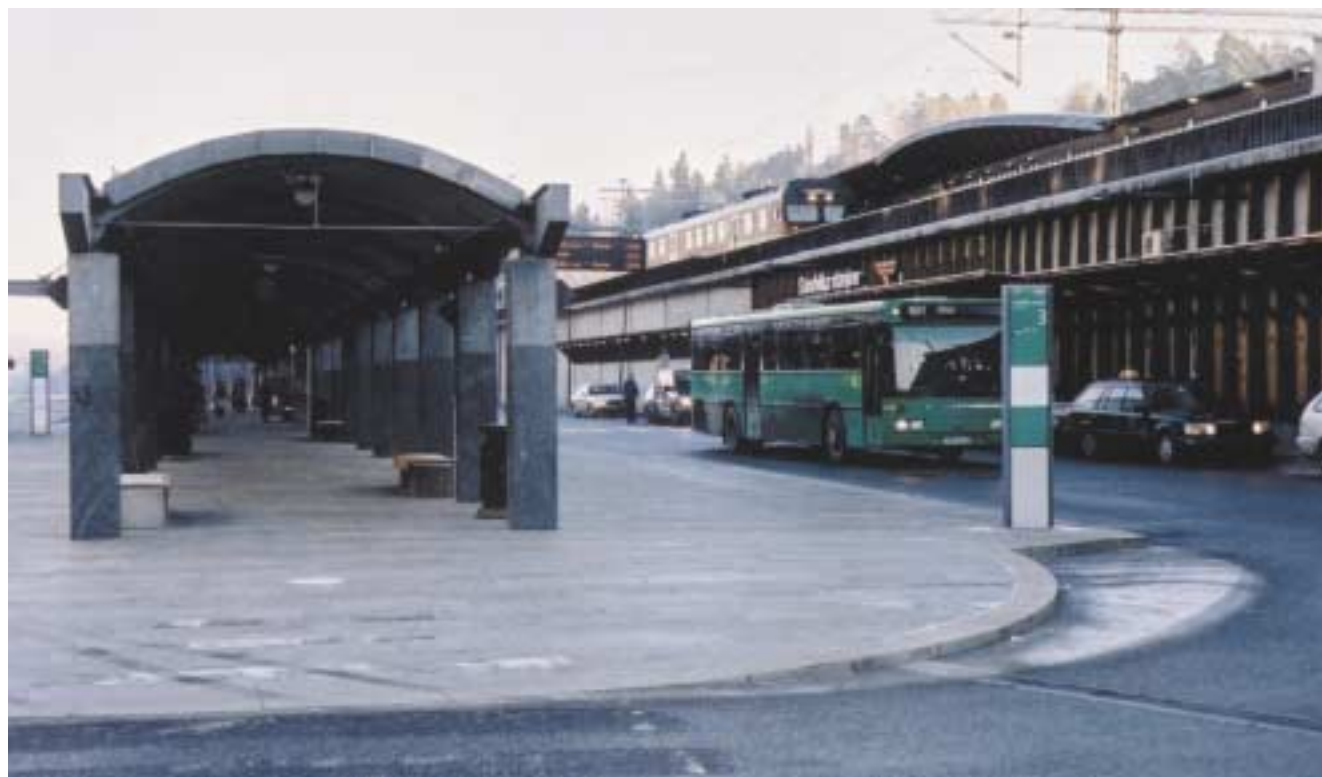
Fra trafikksiden av jernbanestasjonen
