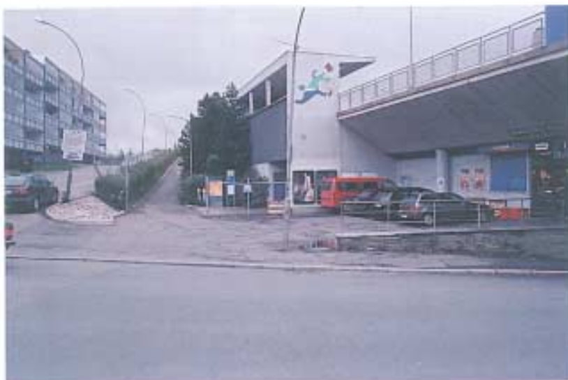
T-banestasjonen ligger over Veitvetveien. Kjøpesenteret ligger rett ved siden av. Trafikkteknisk kunne (gang)forbindelsene vært gode, men arealene skjemmes av dårlig utførelse, planløshet, slitasje, tilfeldighet og parkerte biler.
