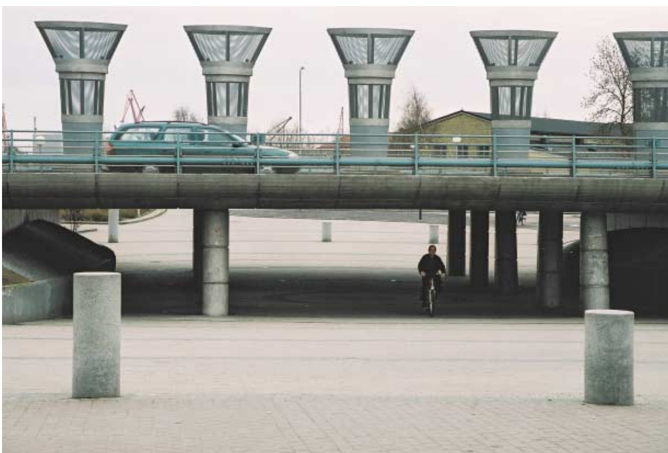
Vakkert utformet fotgjengerundergang
