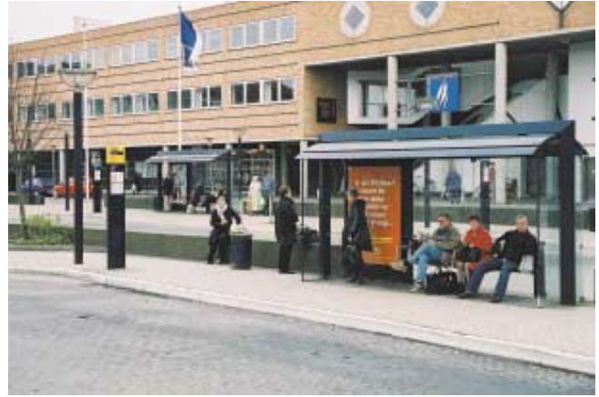
Ny bussterminal ved hovedinngangen
